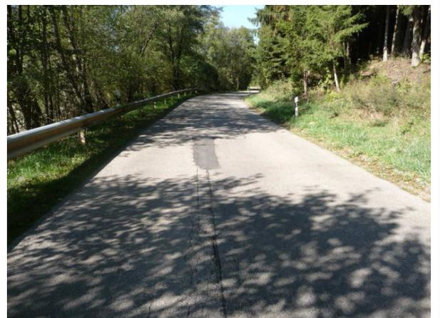
Foto 6: Böschung bergseits rückt ab
